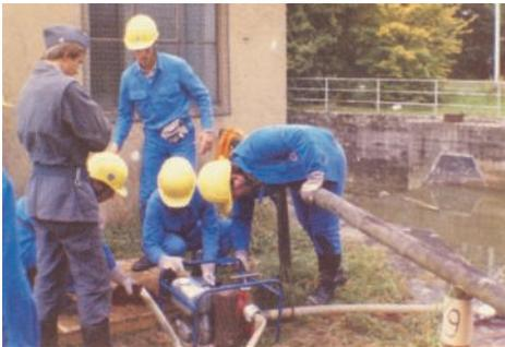
*Der richtige Umgang mit der Schmutzwasser-Kreiselpumpe wurde geprüft. (1986)*
